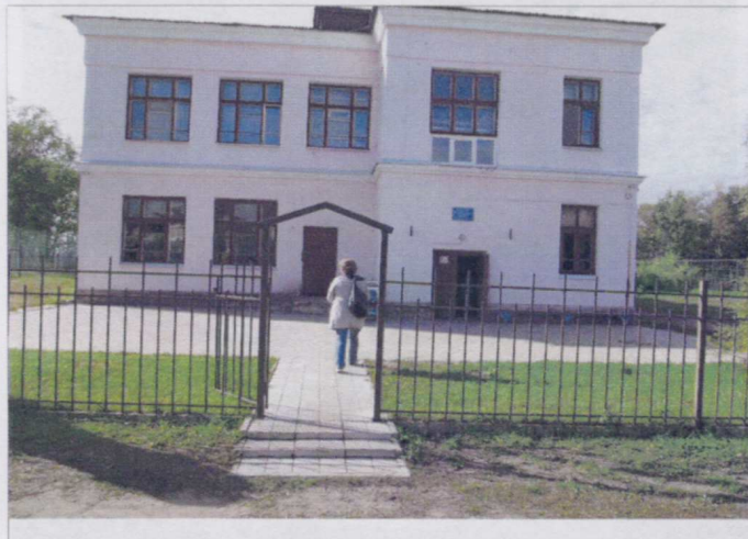
Фото №2 – Вход на прилегающую территорию
